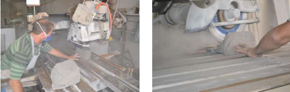
Figura 3.4 – Tentativas de corte a seco realizadas na Marmoraria Oxpiso. Em ambas fotos, nota-se a poeira gerada no corte, além da insuficiência de altura para cortes em apenas uma etapa em razão do flange da serra diamantada
